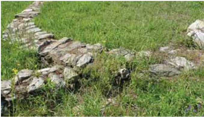
Estrutura 6. Estado inicial. Vista de detalle
