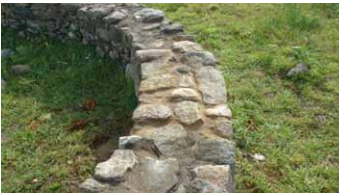
Estrutura 3. Estado final. Vista de detalle
