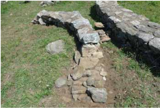
Estrutura 1. Estado inicial
