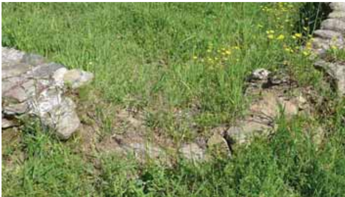
Estrutura 5. Estado inicial. Vista de detalle
