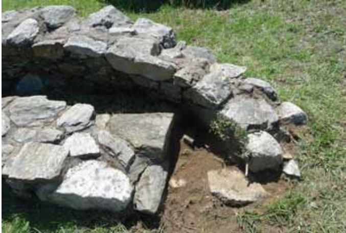
Estrutura 2. Estado inicial. Vista de detalle
