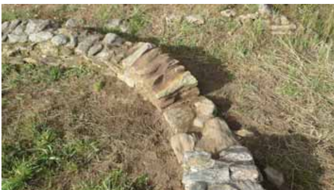
Estrutura 5. Estado final. Vista de detalle
