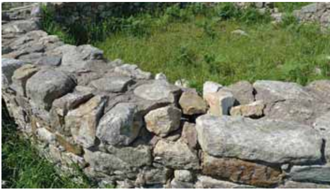
Estrutura 3. Estado inicial. Vista de detalle
